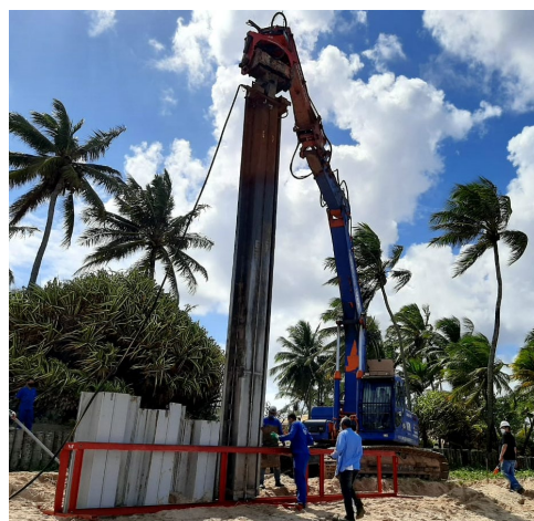
Figura 3. Cravação de Estaca Prancha Vinílica com uso de Martelo Vibratório
