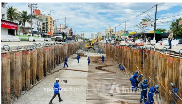
Figura 8. Estaca prancha metálica aplicada encaixada em uma obra de canalização de córrego em Praia Grande-SP.
