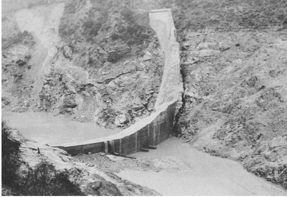
Figura 2 - Vista da ombreira direita após o desabamento. Fonte: Post e Bonazzi (1987).
