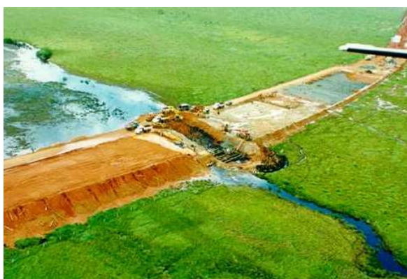
Figura 1. Vista aérea do aterro estaqueado da ferrovia na ponte sobre o Rio Laje em Chapadão do Sul, MS.
