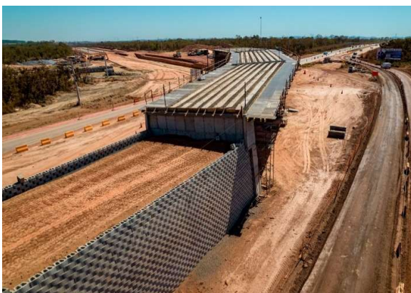
Figura 15. Vista da contenção do encontro do viaduto.
