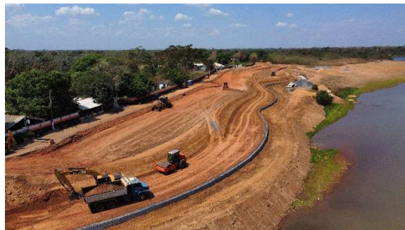
Figura 20. Vista aérea da execução do aterro compactado.
