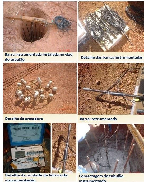
Figura 6. Detalhe da montagem da instrumentação.
