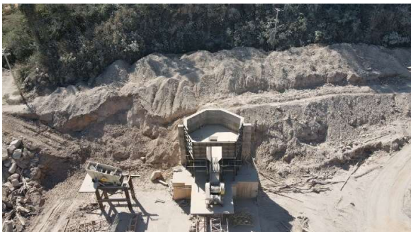
Figura 7. Situação antes da execução dos muros em solo reforçado.
