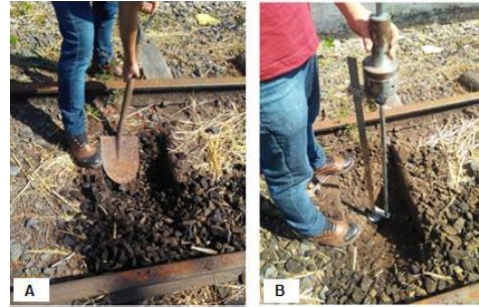
Figura 4. Posicionamento do equipamento para ensaio de DCP.
