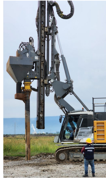
Figura 1. Execução Coluna de Brita Compactada
