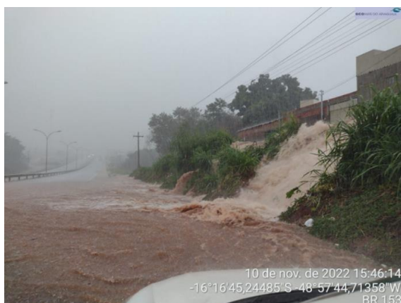
Figura 1. Vista geral do talude sob ação das águas pluviais.
