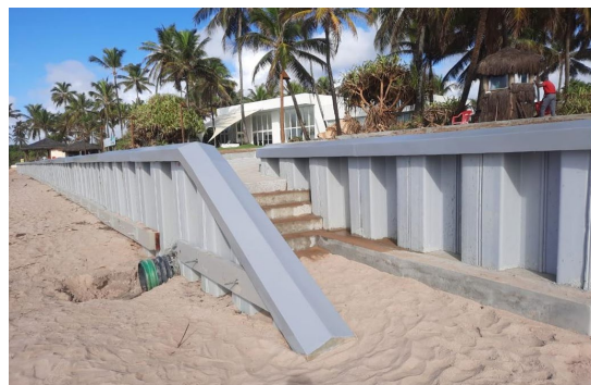
Figura 01. Contenção costeira com uso de Estacas Prancha Vinílicas
