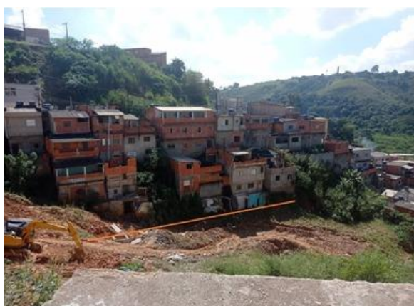
Figura 3. Contenção de encosta com o logblock .
