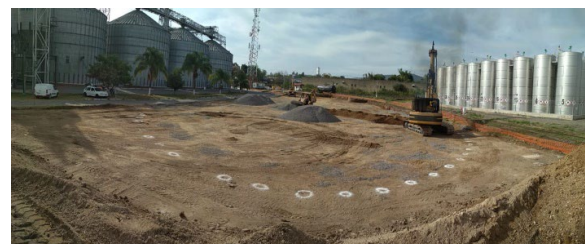
Figura 4. Processo de execução
