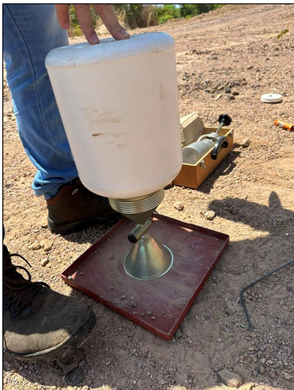
Figura 5. Ensaio de controle de compactação.
