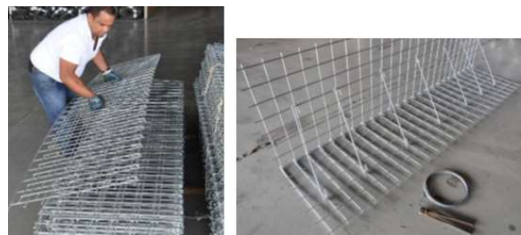
Figura 4. Módulo metálico fechado e aberto estabilizado com as mãos francesas.
