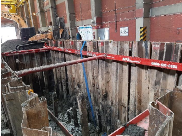
Figura 6. Estroncamento modular fixo em uma obra industrial com Cubatão-SP.
