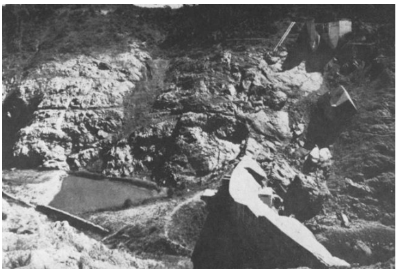
Figura 4 - Fraturas da face esquerda. Fonte: Post e Bonazzi (1987).
