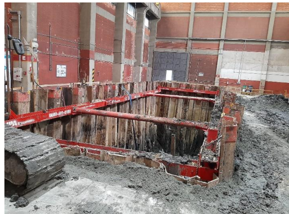
Figura 5. Estroncamento modular fixo em uma obra industrial com Cubatão-SP.
