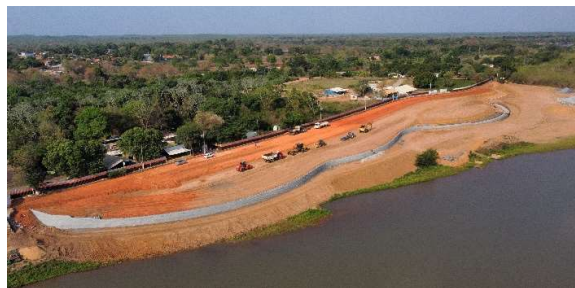
Figura 21. Vista geral da obra em andamento.
