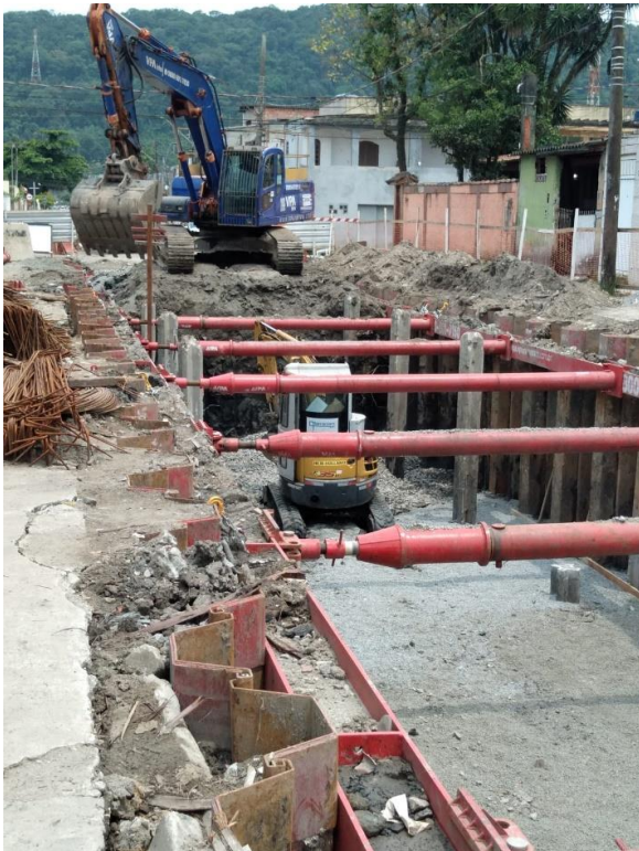
Figura 3. Estroncamento modular aplicado com estaca prancha.
