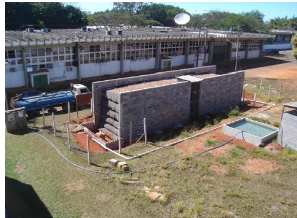
Figura 4. Visão geral do sistema de inundação da fundação dos muros experimentais
