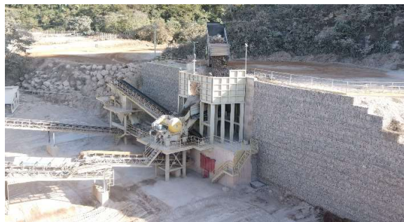
Figura 9. Muros de acesso ao britador concluídos.
