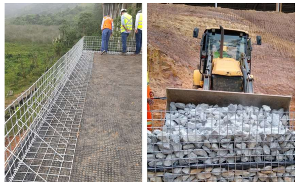
Figura 5. Montagem dos módulos de face e preenchimento com rachãozinho na face.
