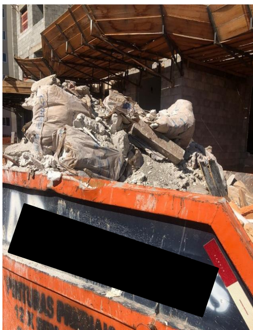
Figura 7. Caçamba com gesso (Autores, 2021).
