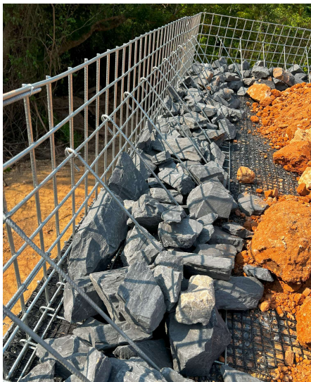
Figura 11. Colocação das pedras na face
