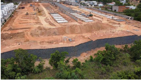
Figura 10. Vista aérea da contenção aos fundos do empreendimento, voltada para APP.
