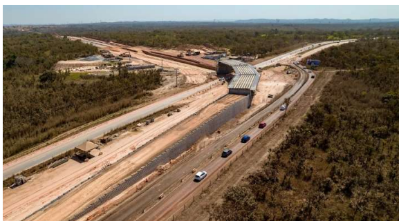
Figura 14. Vista geral da obra.
