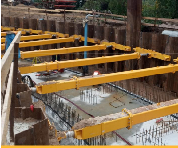
Figura 2. Estroncamento modular aplicado com estaca prancha.
