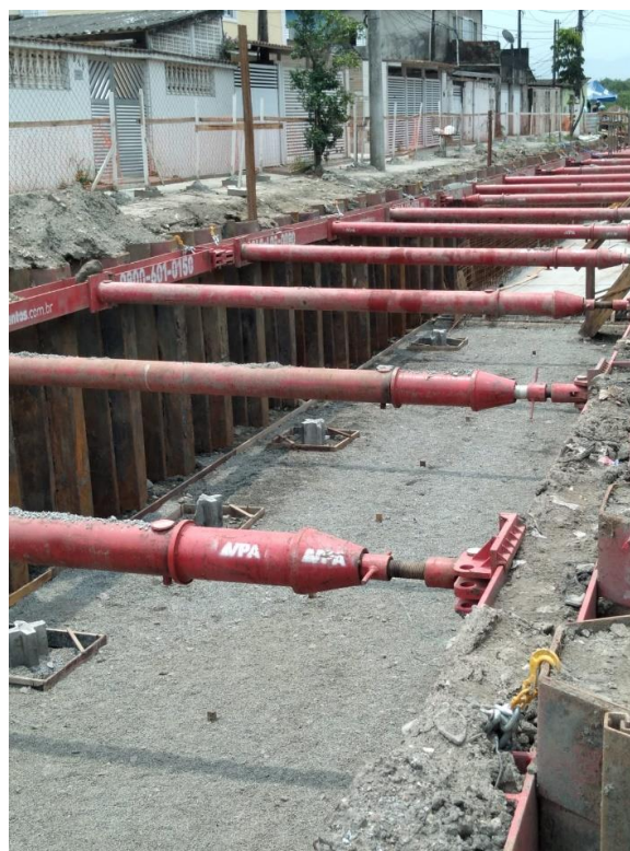
Figura 1. Estroncamento modular ajustável aplicado com estaca prancha em uma obra de infraestrutura localizada em Guarujá-SP.
