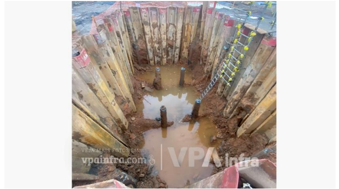
Figura 9. Estaca prancha metálica em uma obra de contenção para execução de blocos de fundação em Camaçari-BA.
